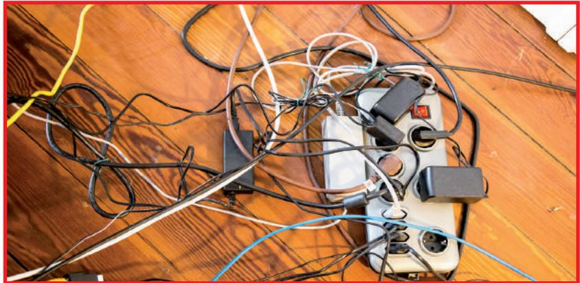
Begünstigt wird die Gefahr meist noch dadurch, dass die Verteilerleisten oft verdeckt (hinter Gardinen oder Schränken) platziert werden. So kommt es zu Stauwärme und die Entwicklung eines Brandes wird schlimmstenfalls erst bemerkt, wenn es schon zu spät ist.
